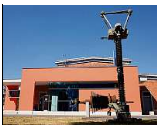
Ein Hochspannungsschalter und Turbinenläufer vor dem August-Kramer-Institut. Foto: Tina Bergknapp
